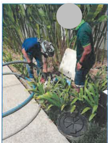
ภาพถ่ายที่ 2.2-19 การสูบน้ำในถังเกราะ
