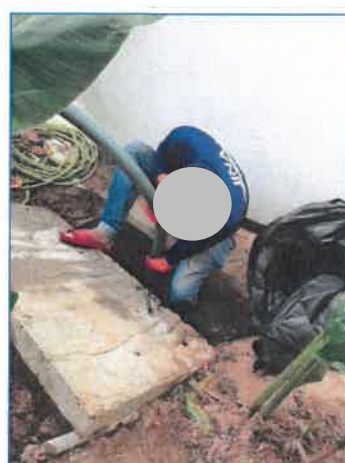
ภาพถ่ายที่ 2.2-19 การสูบน้ำในถังเกราะ
